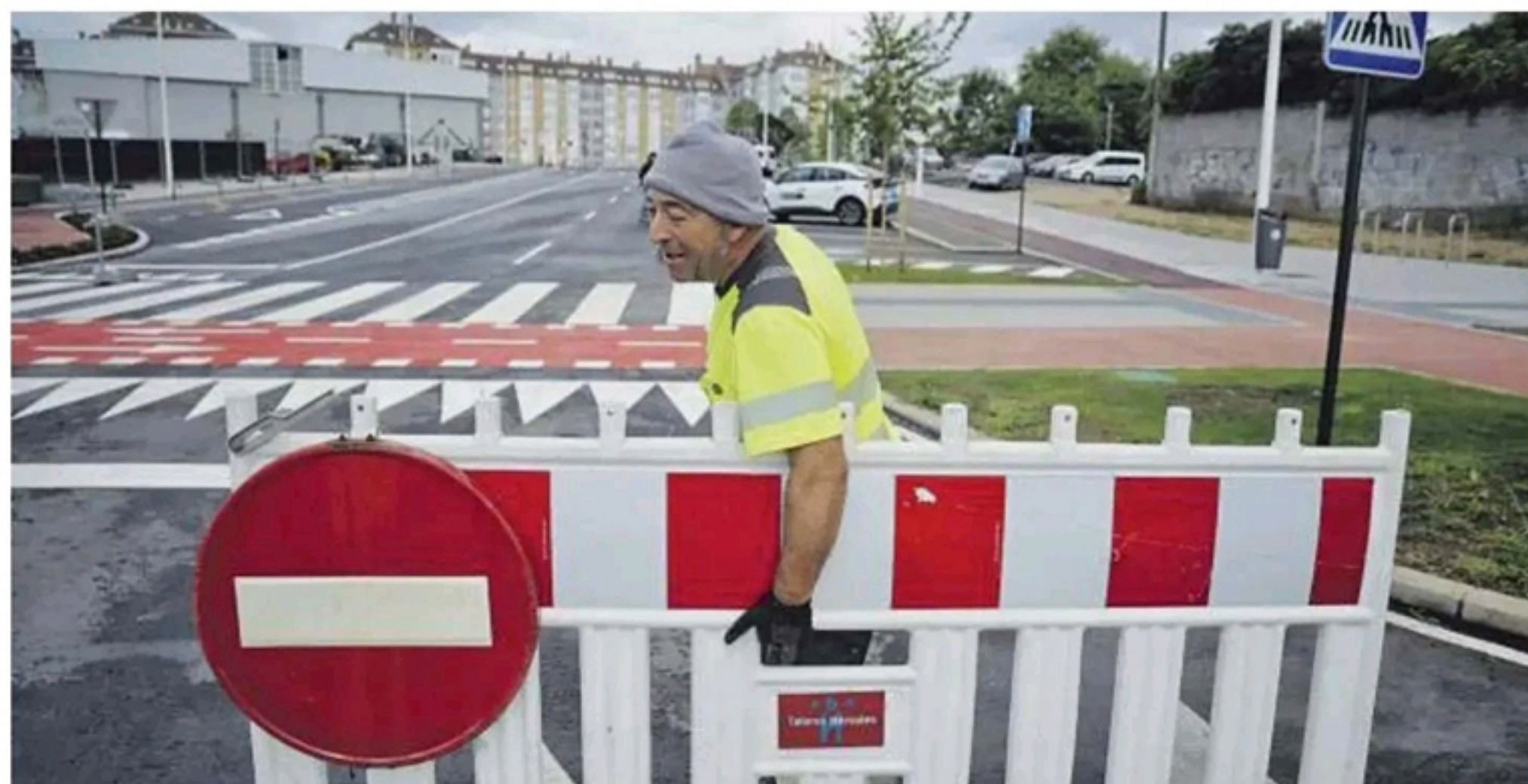
Un operario retira la valla para abrir al tráfico la nueva ronda del Agra dos Mallos, un enlace con la estación intermodal. MARCOS MÍGUEZ
